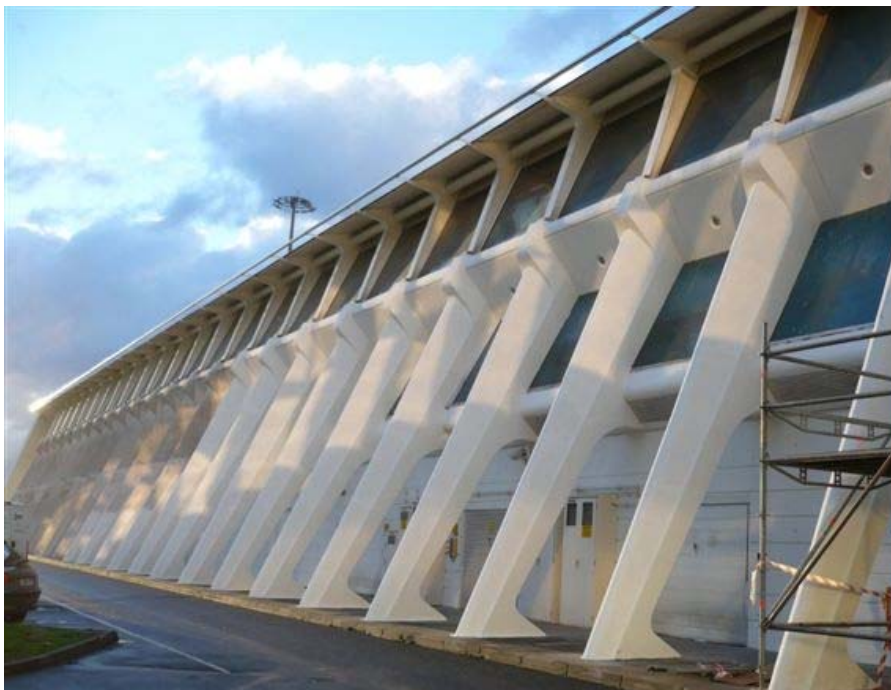
Momento intermedio de la obra dónde se aprecia la zona recubierta con la pintura
