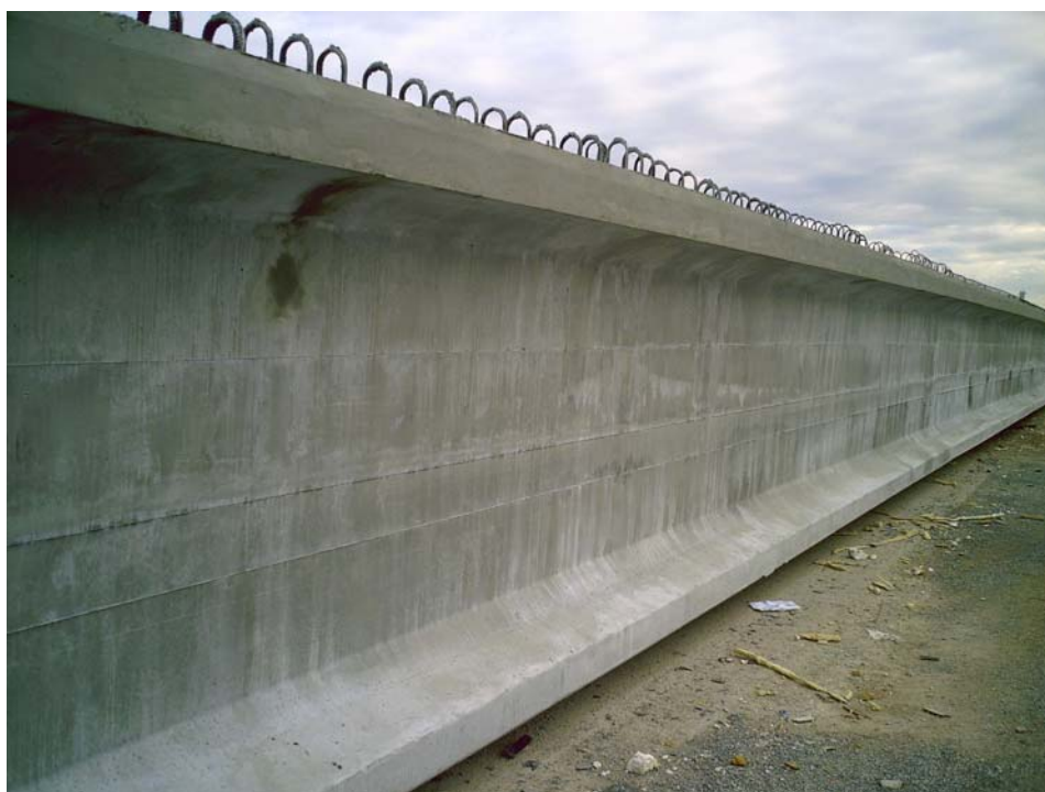
Aspecto final de una de las vigas.
