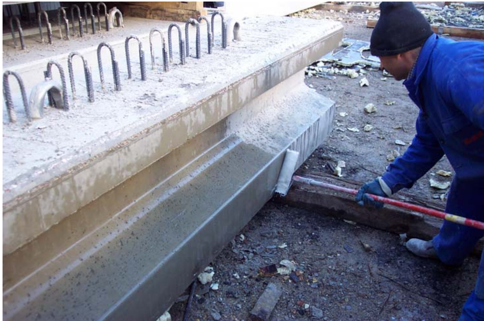
Momento de la aplicación del inhibidor MCI-2021 en la planta de prefabricados
