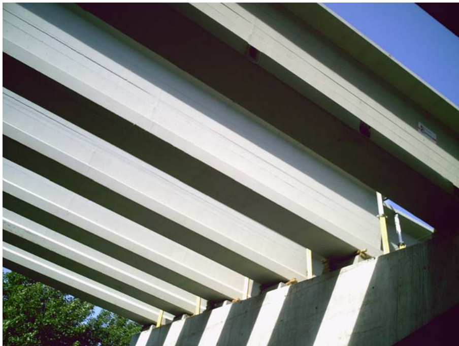
Aspecto final de las vigas colocadas.
