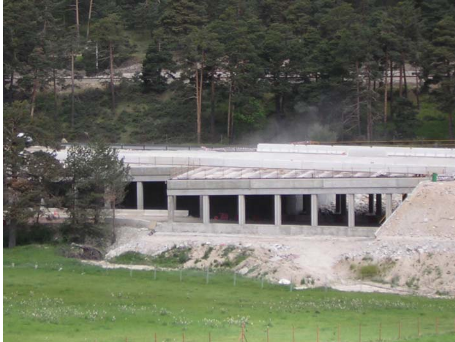
Uno de los viaductos protegidos.
