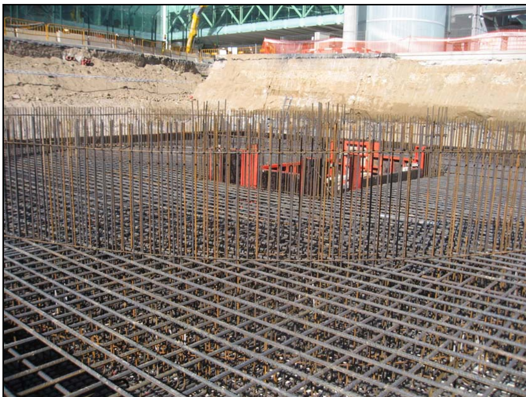
Aspecto general de la losa.
