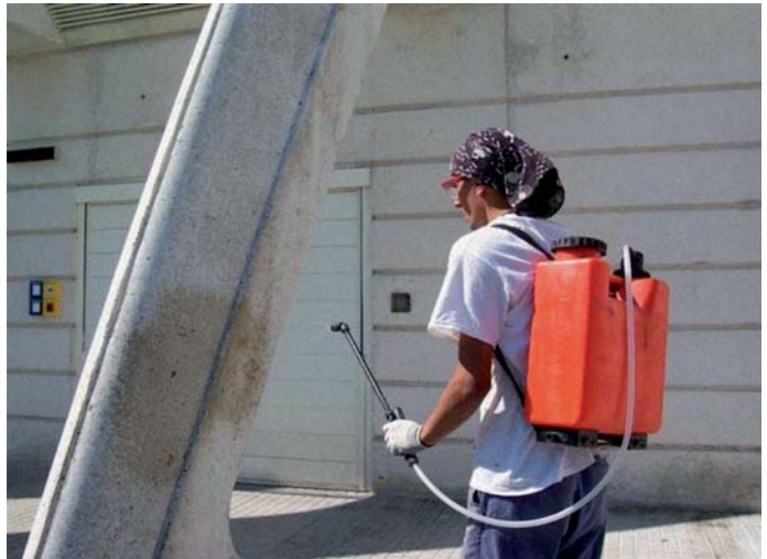
⇒ Figura 11.- Aplicación de inhibidores MCI sobre la superficie del hormigón.
