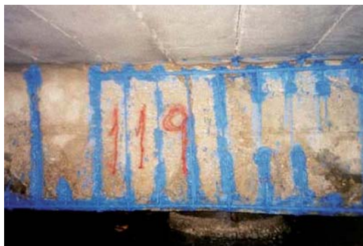
Figura 12.- Aplicación de lechada pasivante sobre el acero desnudo.
