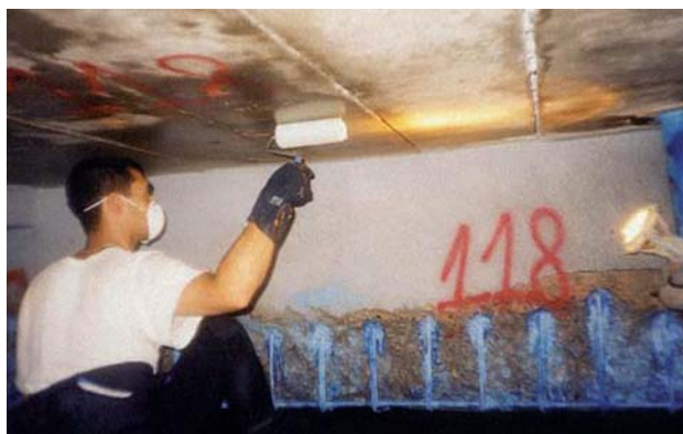
Figura 13.- Aplicación de inhibidores MCI en superficies próximas al área de reparación.
