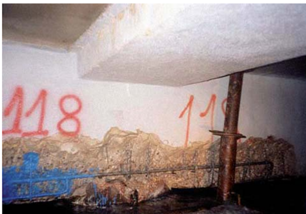
⇒ Figura 10.- Proceso de reparación de una estructura afectada por corrosión.
