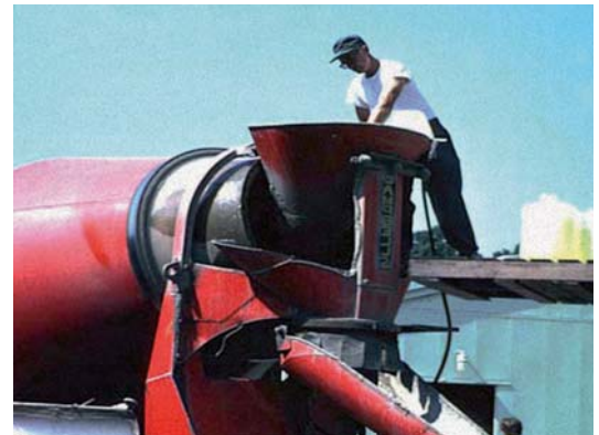
Figura 6.- Incorporación de inhibidores de la corrosión durante el amasado del hormigón.
