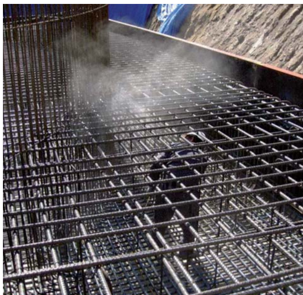
Figura 9.-Detalle de la aplicación mediante pistola del inhibidor MCI sobre la armadura.
