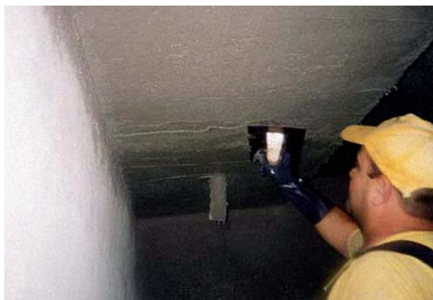
Figura 14.- Aplicación del mortero de reparación.
