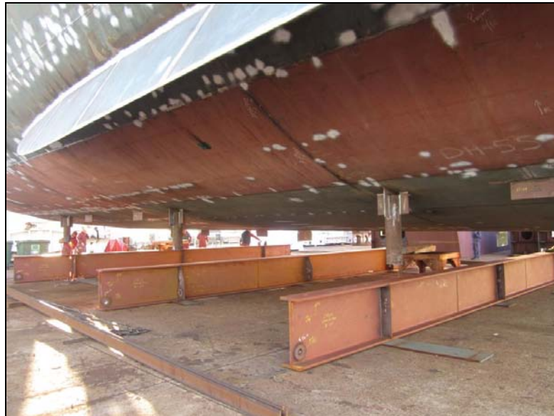
Una de las piezas apoyadas en la cuna antes de su protección.
