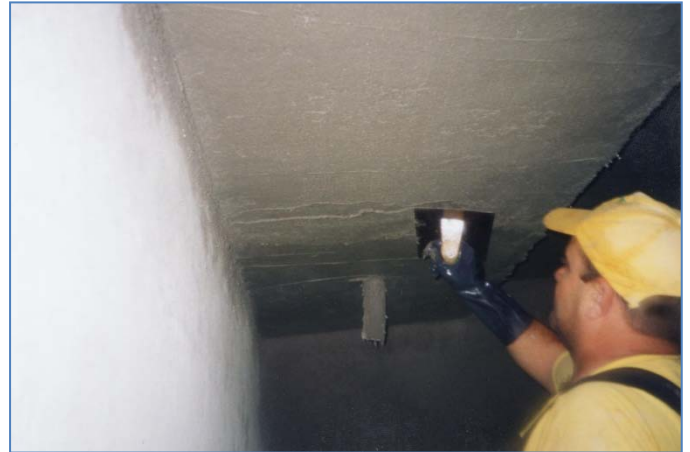
6 y 7.- Dos ejemplos de aplicación de producto MCI como lechada y como mortero de reparación.
