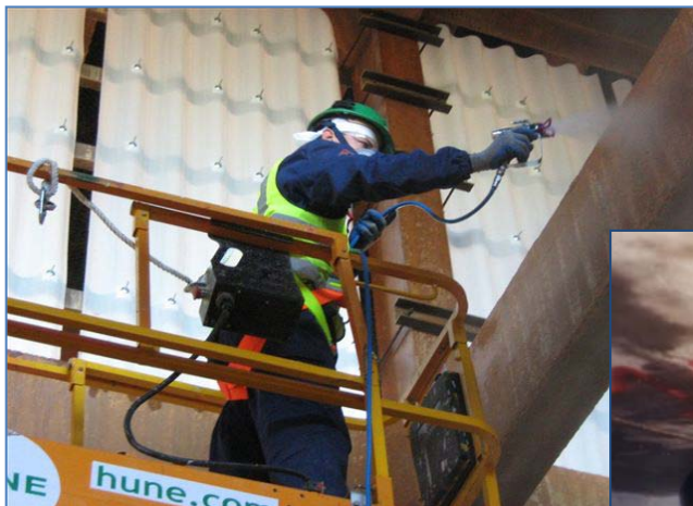
8 y 9.- Momento de la aplicación de un inhibidor de corrosión migratorio en superficie.
