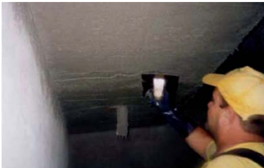
Fotografías 6 y 7.- Dos ejemplos de aplicación de producto MCI como lechada y como mortero de reparación.
