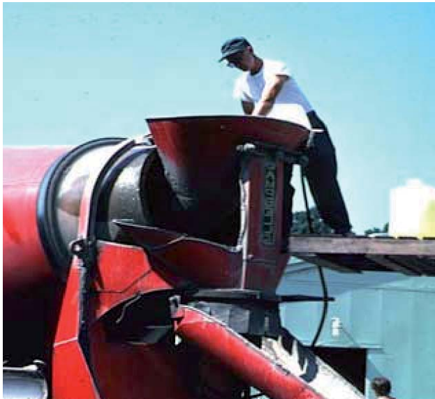
➔ Fotografía 4. -Incorporación durante el amasado de los inhibidores MCI en forma de polvo.
