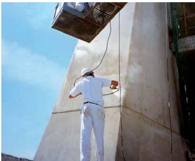
⇒ Fotografías 1 y 2. - Aplicación mediante rodillo y pistola de los inhibidores MCI.
