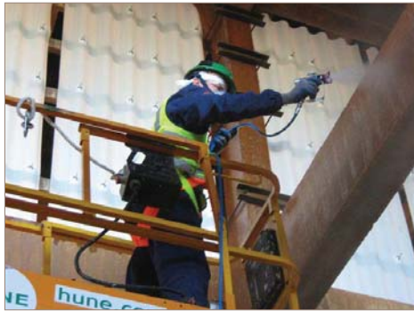
■ Figura 3. Momentos de la aplicación de un inhibidor de corrosión migratorio en superficie.
