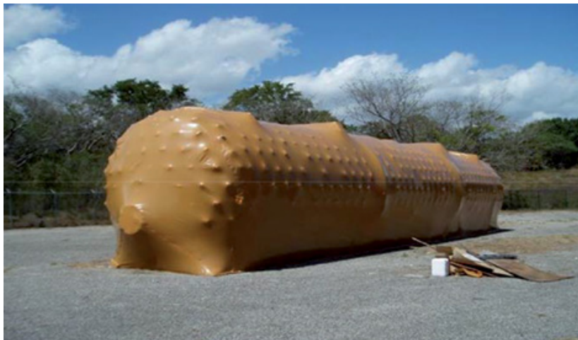
FIGURA 11. Aplicación de film VCI en equipo de grandes dimensiones
