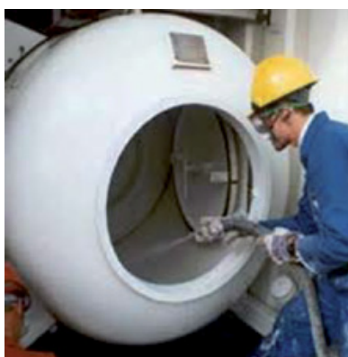
FIGURA 7. Aplicación del inhibidor en polvo en el interior de un equipo
