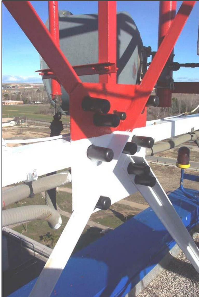
Aplicación de VpCI-368 y encapsulado
