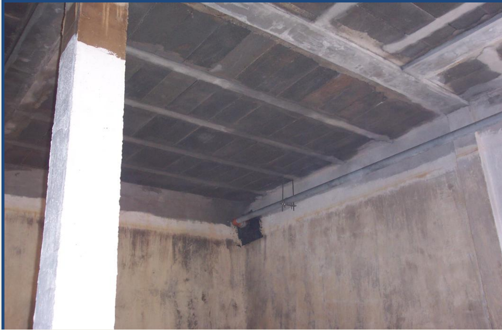
Aspecto final de depósito reparado con el mortero Q-2039.
