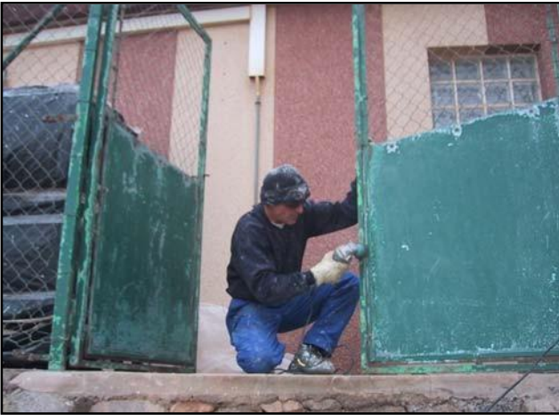
1.-Preparación de superficie
