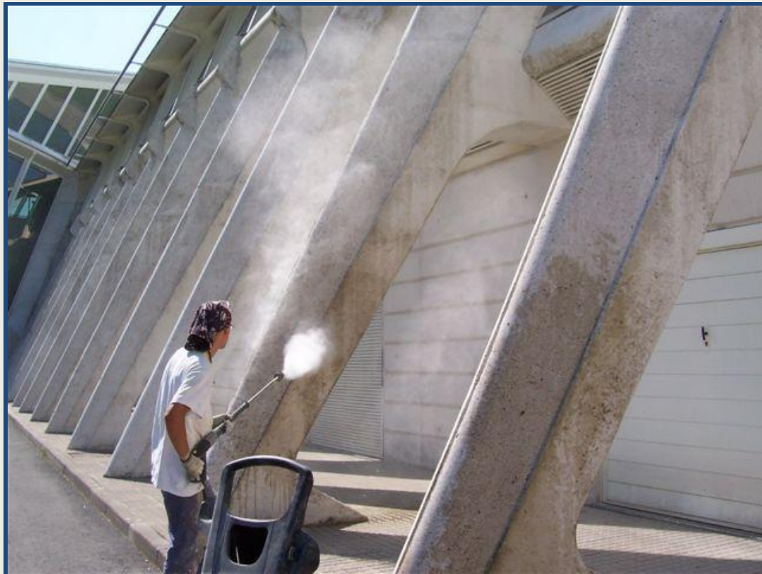
Momento de la limpieza para eliminación de impurezas y suciedad.
