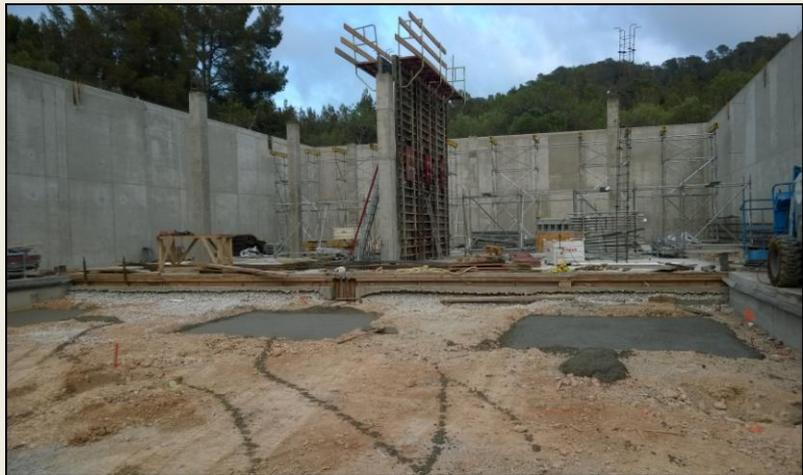
Una vez establecida el tipo de problemática existente y las consideraciones de potabilidad, se aditiva el inhibidor de corrosión MCI-2005, inhibidor de corrosión migratorio en base aminocarboxilato que protege las armaduras de hormigón embebidas frente a los ataques por cloruros y carbonatación, el producto se dosifica a razón de 0,6 l/m<sup>3</sup> y cumple con la NSF Standard 61 para su uso en contacto con agua potable.
