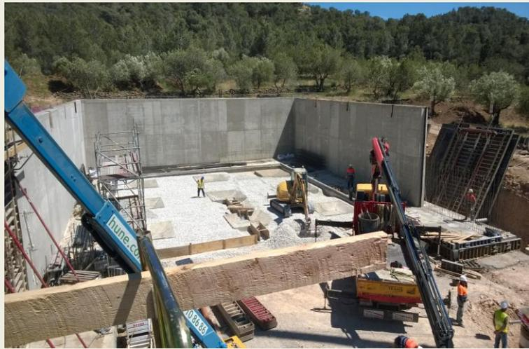
La solera del depósito está formada 2 losas independientes de hormigón armado de 0,30 m de espesor y de 18,75x17,00 m. La entrada y salida del depósito se realizan por la solera de hormigón de 30 cm y con diámetro de 1.200.
