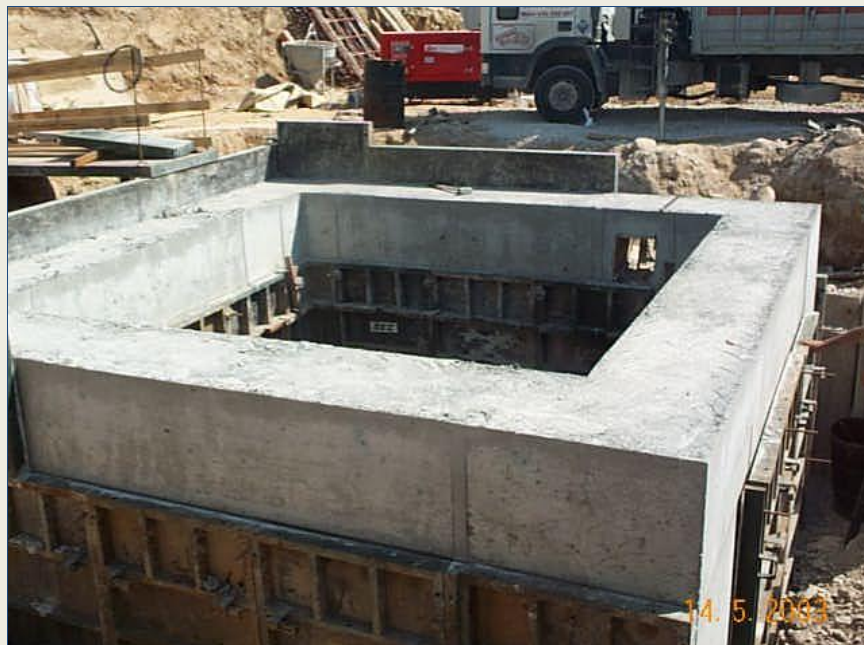
Arqueta de inicio de la obra de vertido.
