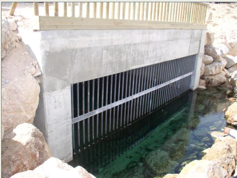
Aspecto de la arqueta de vertido.
