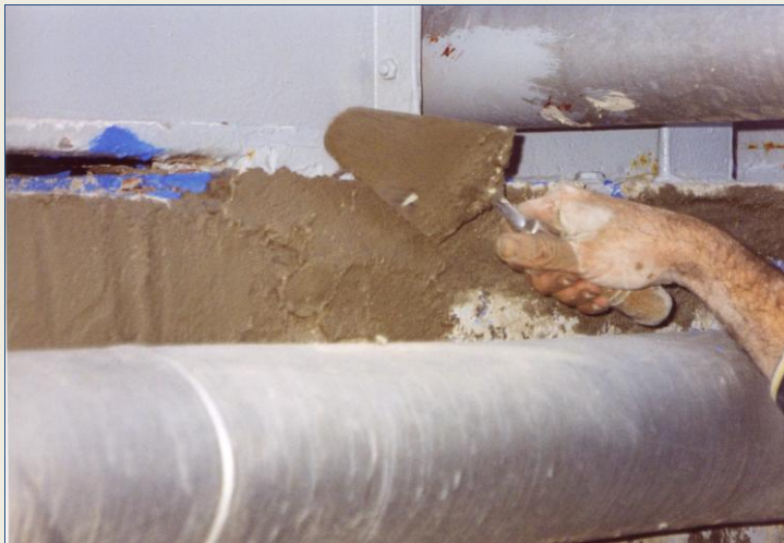
Dos momentos de la reparación llevada a cabo con el producto Q-2039 con herramientas de enlucido normales.
