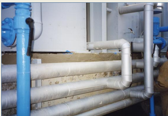
Aspecto de la reparación de los soportes.
