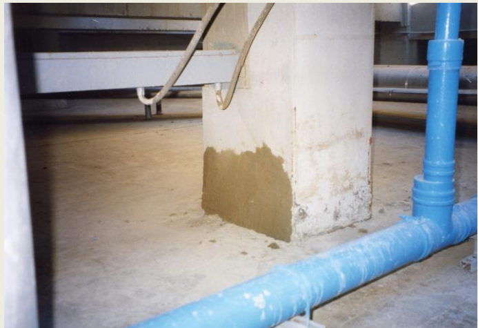
Aspecto de la reparación de los soportes.
