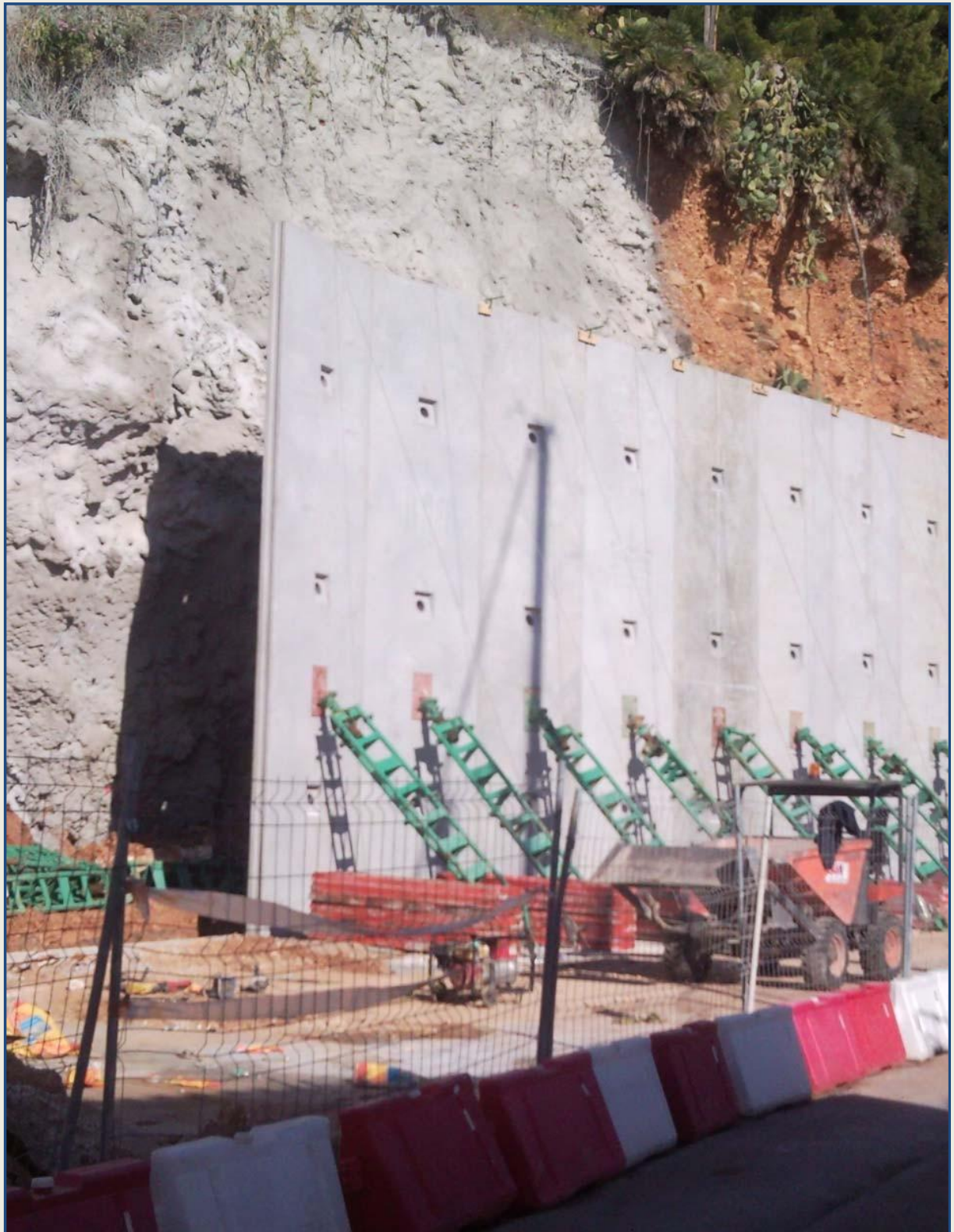
Momento de la instalación de las placas prefabricadas
