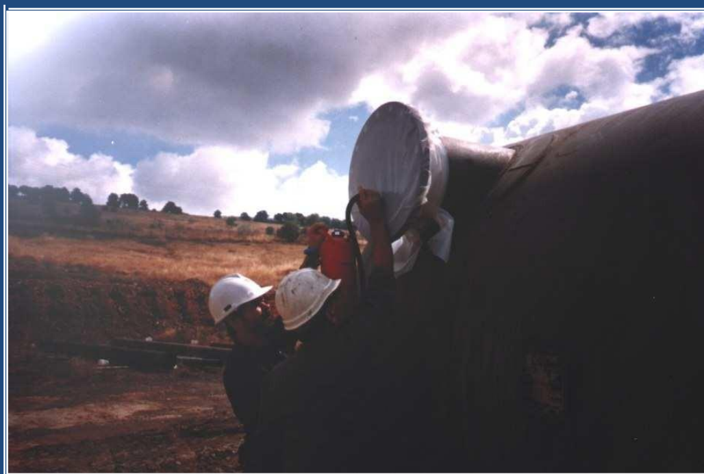
Pulverizado del producto VCI-609 en la unidad F-952.
