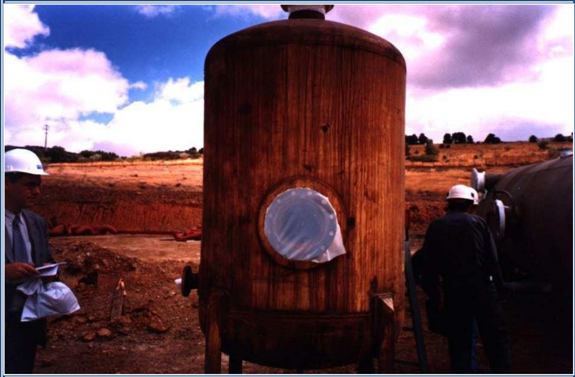
Detalle del sellado del equipo tras la aplicación del producto.
