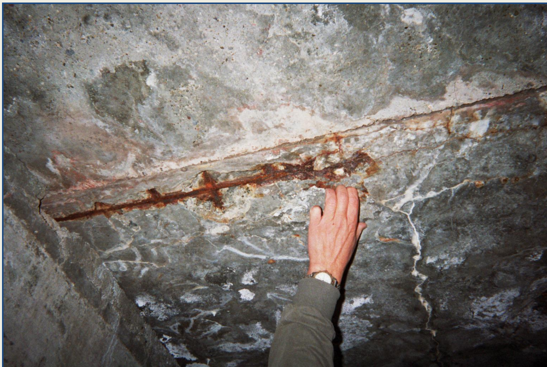
Imagen en la que se comprueba la facilidad para desprenderse el material.
