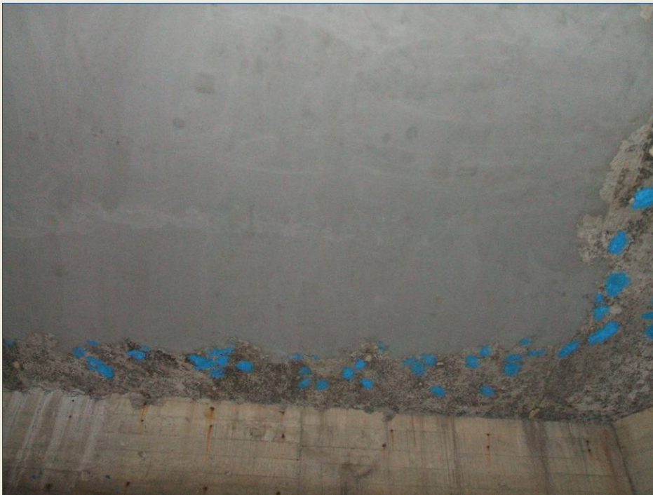
Detalle de la aplicación del mortero de reparación.
