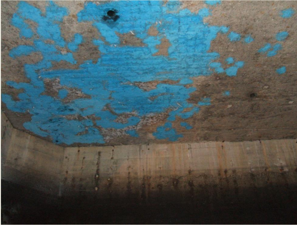
Detalle de la aplicación de la lechada pasivante.
