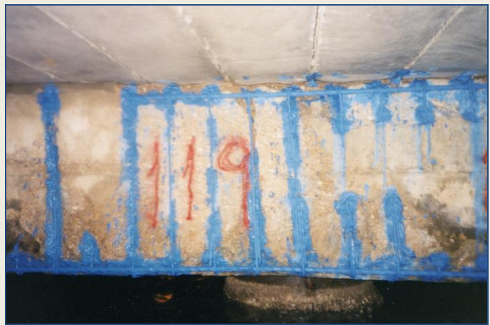
Lechada Q-2023 aplicada.
