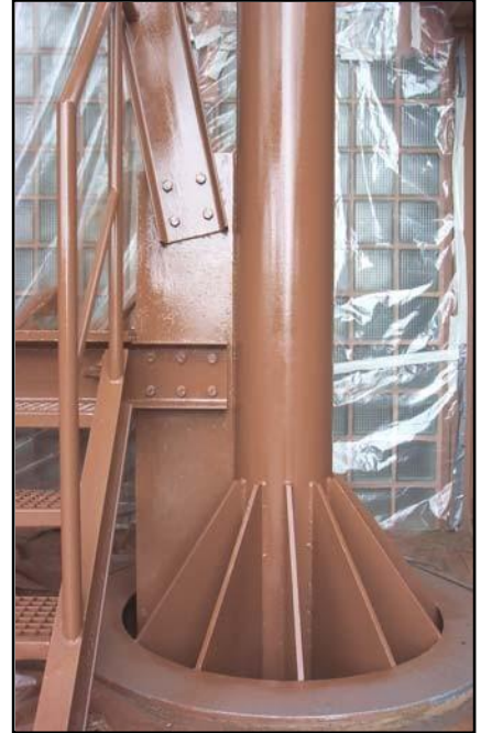
Aplicación de recubrimiento transparente VpCI-386 con un espesor de 35 micras.
